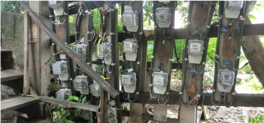
Figure 9 Compteurs électriques et ligne d'électricité alimentant les maisons de Mittakham 2.
